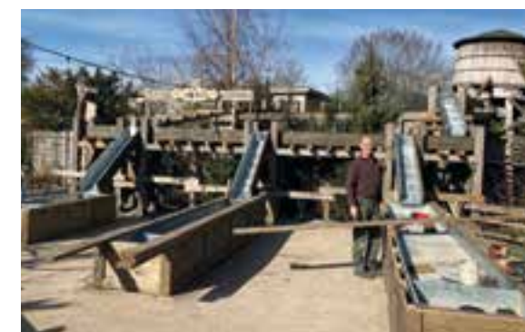
Erneuerung der Goldwaschanlage
