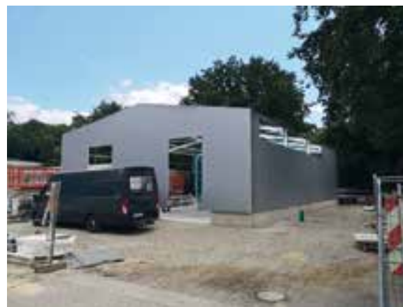
Die Leichtbauhalle entsteht
