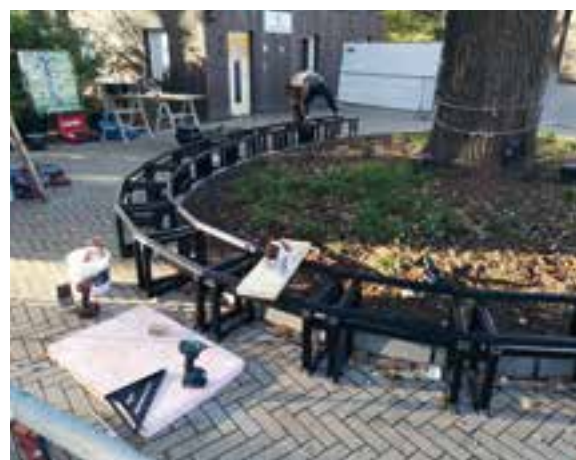
Aufbau der Rundbank-Unterkonstruktion
