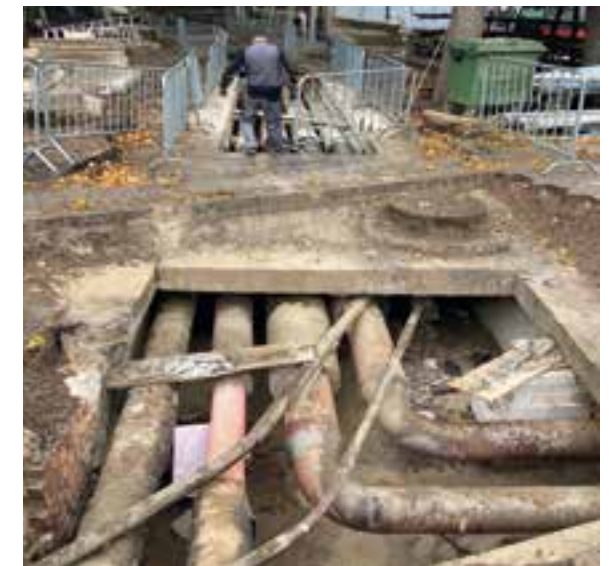
Sanierung der Fernwärmeleitungen
