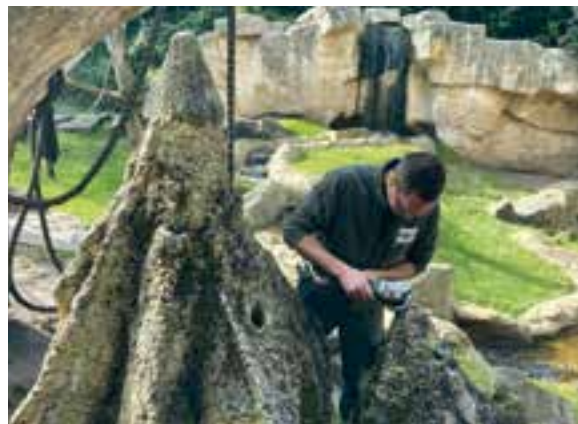
Reparatur des „Termitenhügels“
